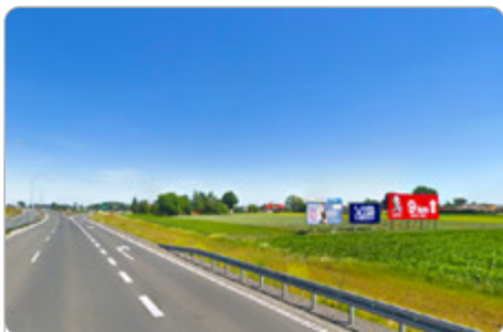
OBWODNICA (KIERUNEK POZNAŃ) DROGA KRAJOWA NR 15 - ZJAZD DO INOWROCŁAWIA
